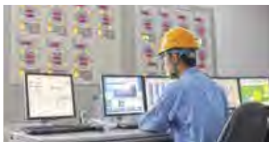
ระบบควบคุมแบบรวมศูนย์ 24 ชั่วโมง
